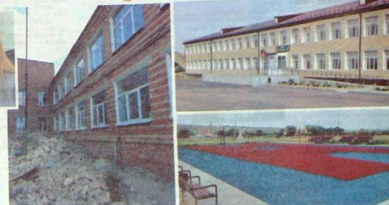
Завершен капитальный ремонт здания Верхнехвостовской школы. Слева снимок сделан в начале работ.
