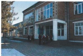
Здание МБОУ ДО «Старостаничный центр эстетического воспитания детей Каменского района»
